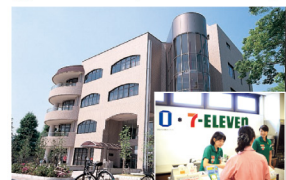
8 南福祉施設(ピーチユニオン)
